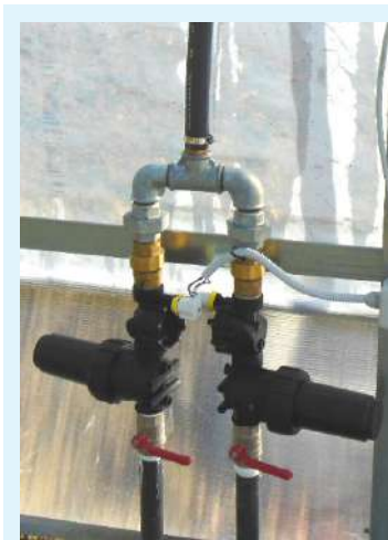
Groupe d'alimentation double, électrovanne, filtre filet et valve solénoïde.
