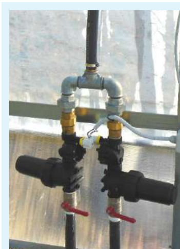
Groupe d'alimentation double, électrovanne, filtre filet et valve solénoïde.
