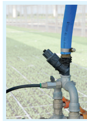
Groupe de distribution d'eau avec électrovanne pour buses le côté et régulateur de pression.
